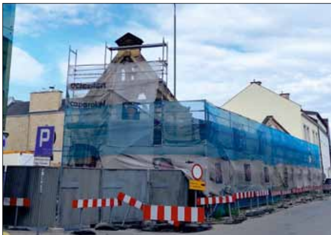
Na działce inwestycyjnej na ul. Sukienniczej trwają wykopaliska. Fot. Janusz Wikowski
