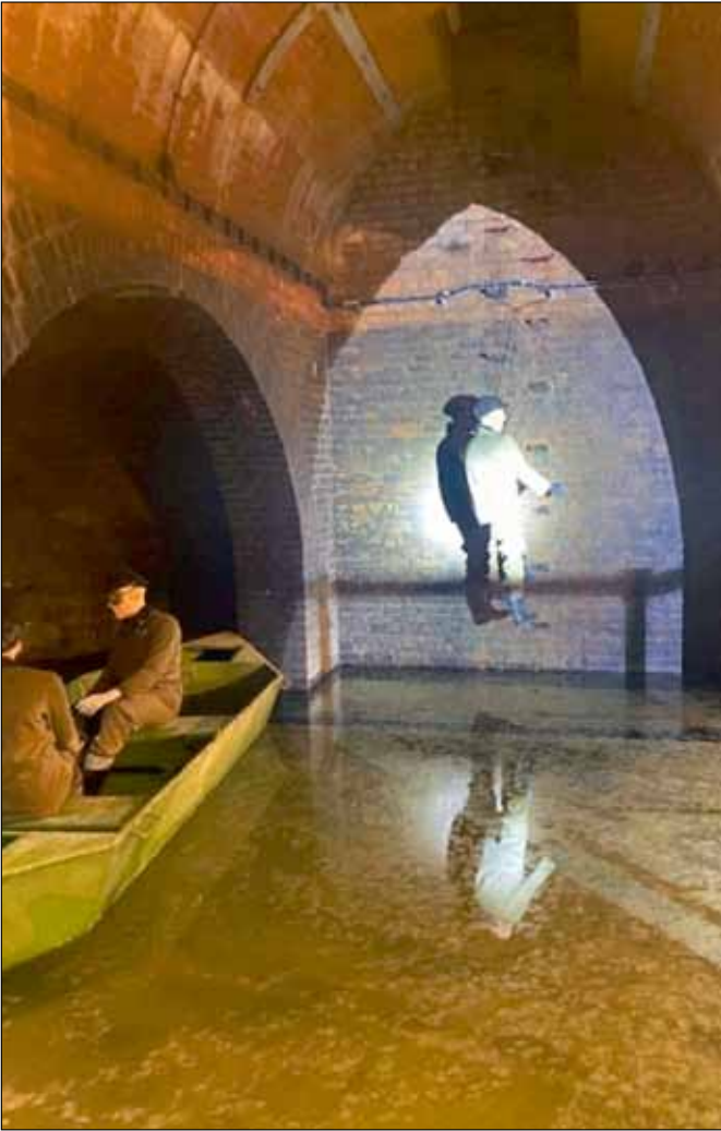
Wnętrze Zbiornika Wody Stara Orunia. Fot. M. Lewandowska
