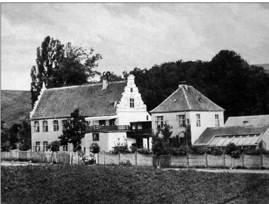
Dwór z tarasem i dom mieszkalny przed 1881 r.
