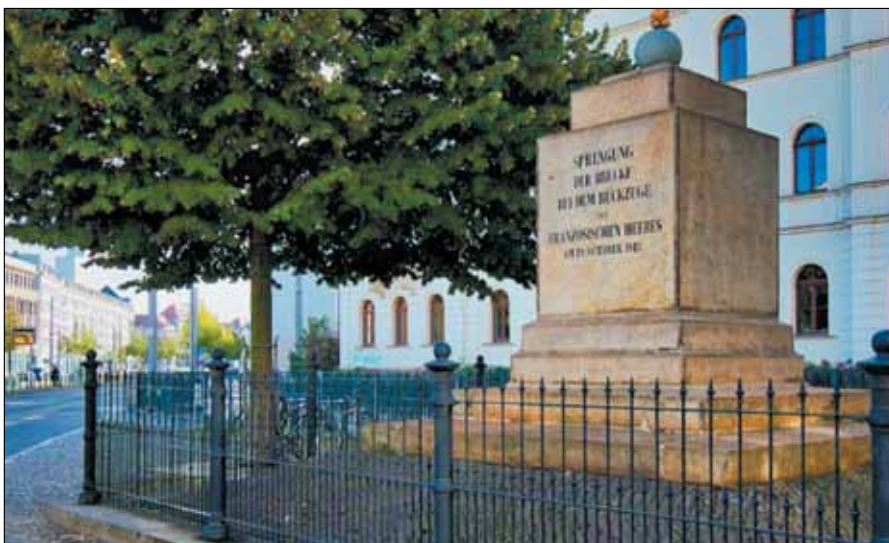
W tym miejscu 19.10.1813 r. saperzy francuscy zbyt wcześnie wysadzili most na Elsterze. Fot. Andrzej Chyra
