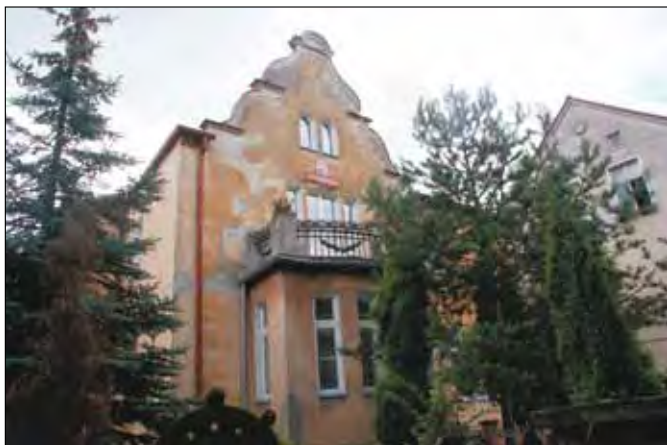
Szkola przed remontem
