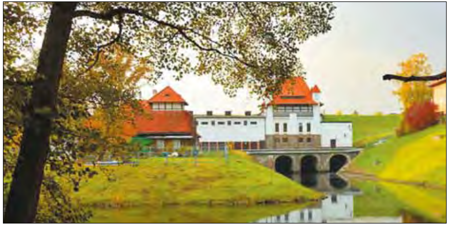
Elektrownia w Straszyńcu
