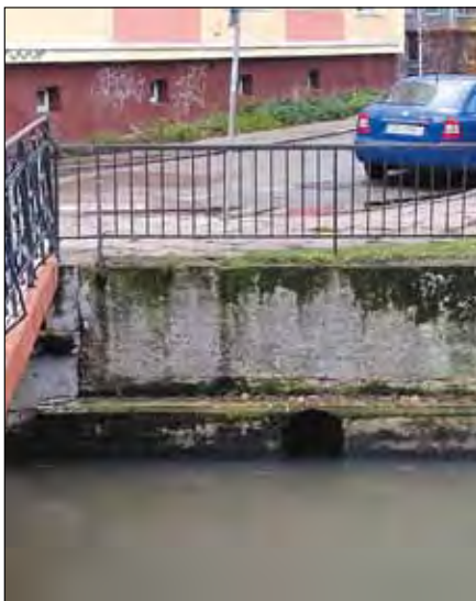
Słabo widoczny wylot kolektora wód opadowych – pozostałość po północnej odnodze Małej Raduni. Zdjęcie autora, 2023 r.
